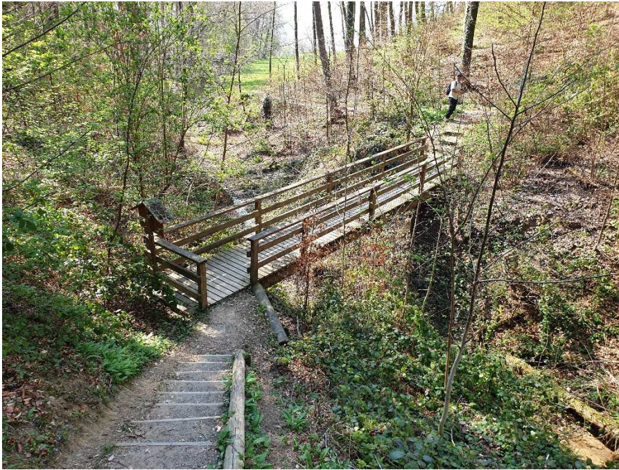
Abbildung 2: Das «Chalchertobel» mit der 2002 von Zimmerlehrlingen erstellten Holzbrücke; Foto M. Menté
